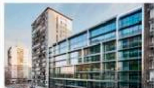
OFICINAS. Edificio Discovery (Madrid) con doble piel de vidrio y lamas horizontales.
